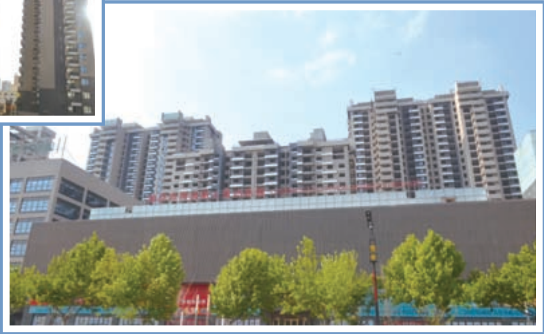
開封迪臣世博廣場 住宅區 Kaifeng World Expo Plaza Residential Area
